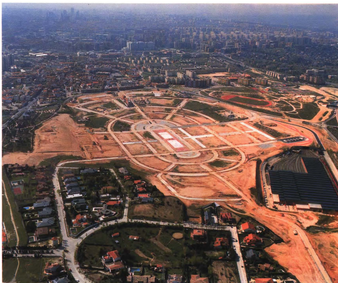
Estado actual de la urbanización.
